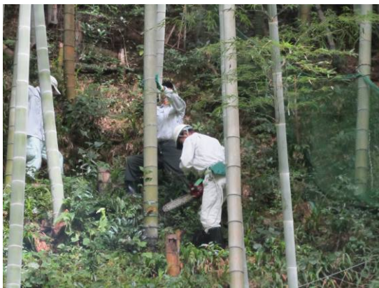
急傾斜地での伐採作業は、危険を伴います。
